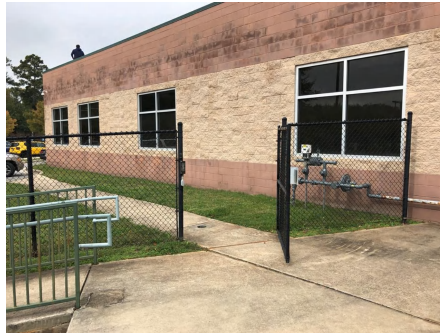
8). Exterior Elevation - Jan 25, 2020
